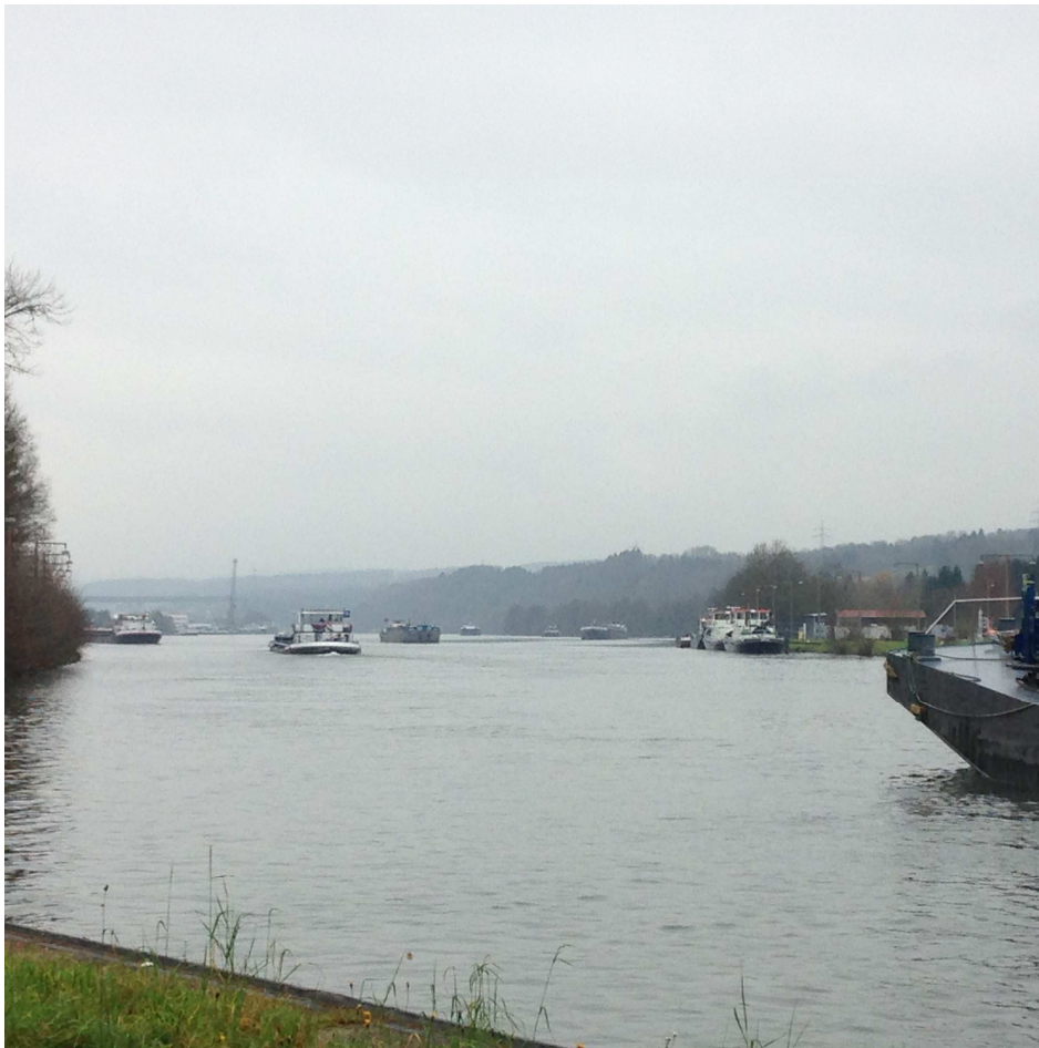
Foto1: wartende Schiffe im Oberwasser der Schleuse Kachlet Quelle: WSA Regensburg
